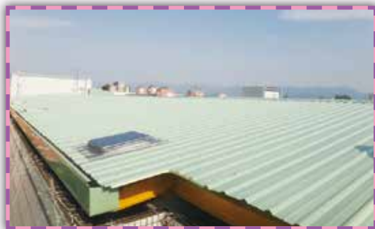
▲教學大樓北棟頂樓防水隔熱工程完工
