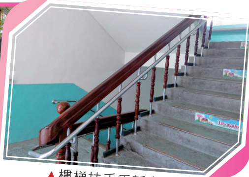
▲樓梯扶手重新上 漆及柱腳固定穩固
